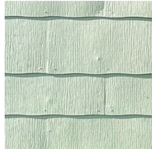
Asbestos siding
